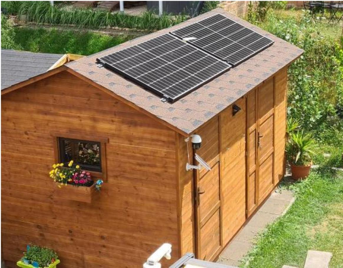
Für die Gartenhütte empfehlen wir unsere Low Cost "Slim" Halterung. Diese ist generell bestens geeignet für Untergründe, die eine direkte Verschraubung ermöglichen und bereits eine Neigung besitzen. Die Halter gibt's [hier](#).
