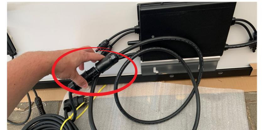
Fertig konfektionierten **Stecker** in die **lange dicke** Leitung vom Wechselrichter stecken.
